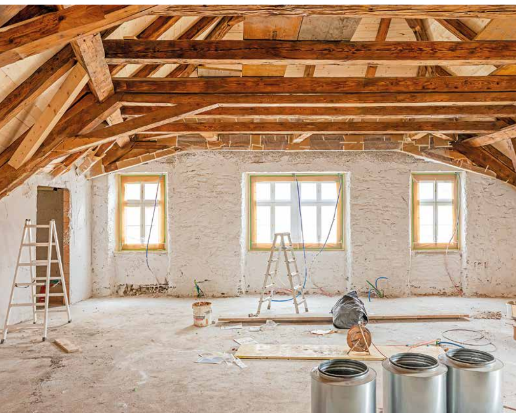
Historische Balkenstruktur im Dachgeschoss. (Bild Yanik Bürkli)
