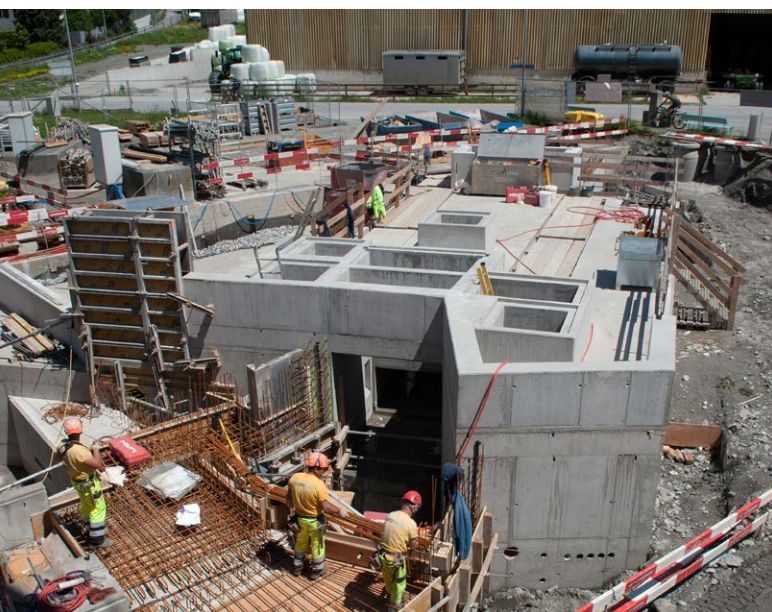
Das neue Rechengebäude ist am Entstehen.
