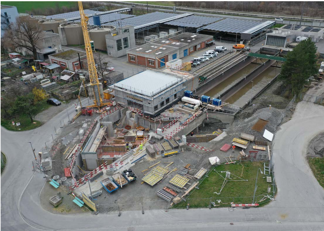
Die ARA Chur im Überblick: Hier werden 5.5 Millionen Kubikmeter Abwasser im Jahr gereinigt.
