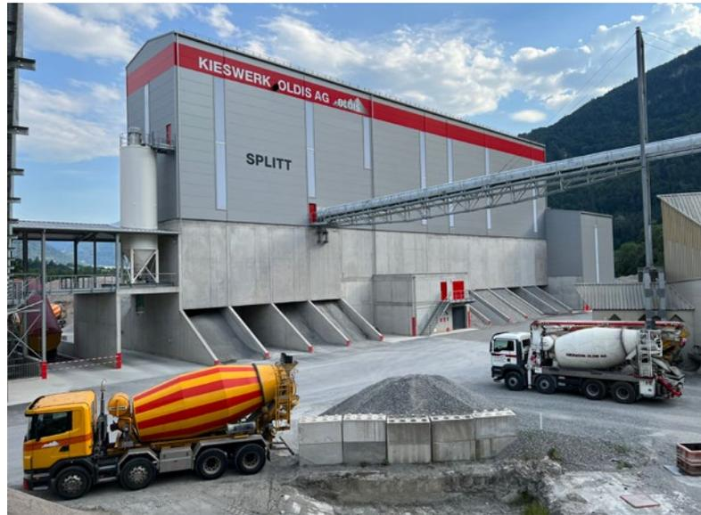
Neue Kiesaufbereitungsanlage für Primär- und Sekundärbaustoffe.
