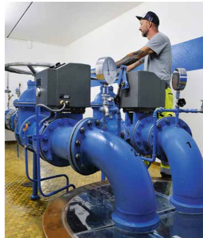
Wasser marsch: Im Pumpwerk Schützenhaus wird bei Bedarf Grundwasser in das Wassernetz gepumpt.
