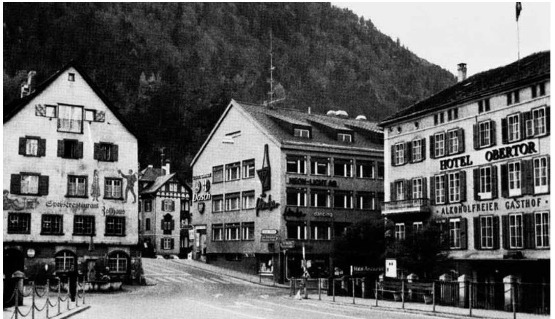
In der Bildmitte sieht man den «Felsenbar-Kelch» kurz nach der Montage an die Wand, links wird das Gebäude flankiert vom Zollhaus und rechts vom alkoholfreien Hotel Obertor.
