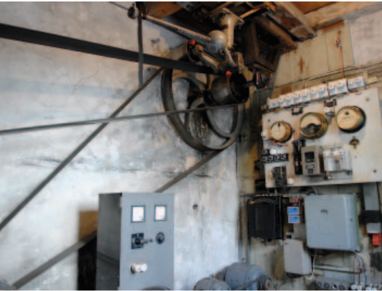
Ein Hauch Nostalgie: Das Kleinkraftwerk Cada wurde in seinem ursprünglichen Zustand saniert.
