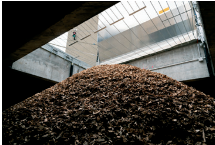
Nachhaltig heizen: Im Wärmeverbund Haldenstein werden Holzschnitzel in hochwertige Wärmeenergie umgewandelt.
