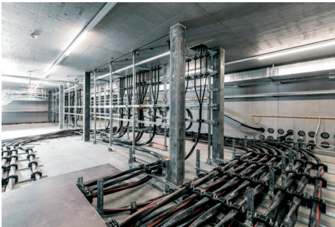
Moderne Anlagen: Im Unterwerk Quader wird der Strom in eine tiefere Spannung umgewandelt und an die Haushalte verteilt.
