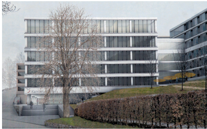
Ein grosser Brocken: Das Kantonsspital Graubünden wird bis 2015 massiv ausgebaut.
