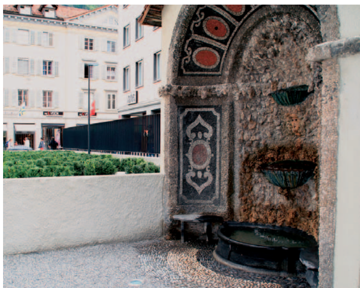
Die Tuffsteingrotte aus der Barockzeit wurde vor 10 Jahren saniert.
